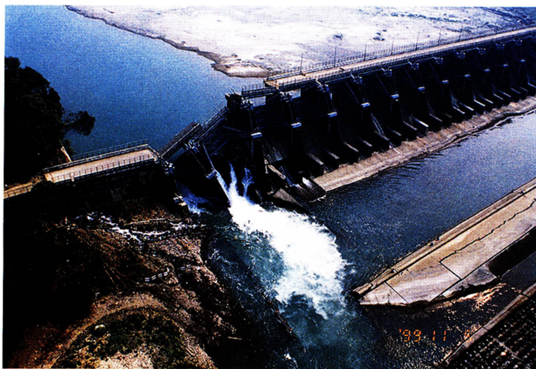
照片二、石岡水壩受到斷層作用而在北邊壩址造成潰壩，照片中右方（即南邊）的水壩壩體及其前後方大片出露的土地，係地震後整片被抬昇而造成的結果。
