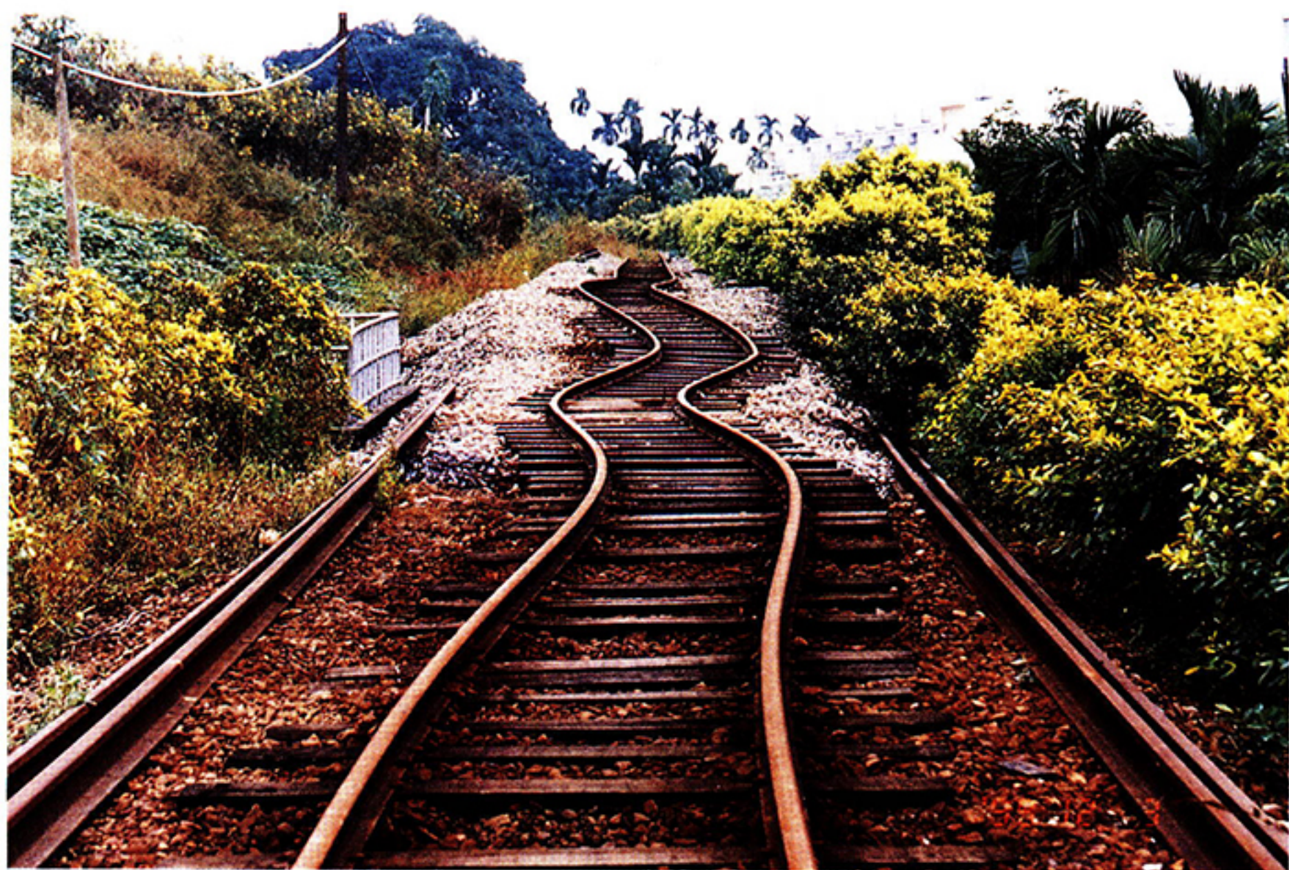
照片九、集集線鐵路於集集大地震中也受到極大的破壞，因為受到橫向地震力激烈的作用而造成鐵軌扭曲變形。
