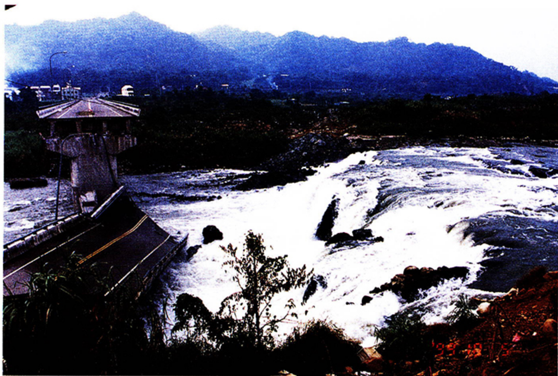
照片一、大甲溪上的埤豐大橋受到斷層切割而斷落，斷層切過橋樑後仍繼續往東北邊延伸，且在大甲溪上河床的岩盤造成一處約五公尺高的瀑布。
