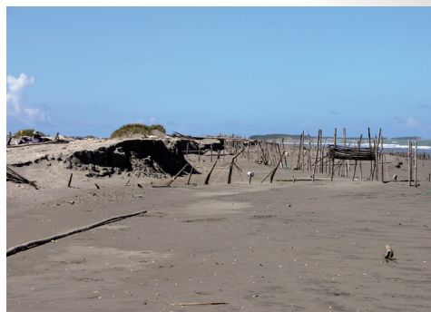
照片3、2004年網子寮汕上的人工抽沙養灘區，因海岸侵蝕而出現陡崖。崖前成排的竹架是原先人工養灘區內的格區欄柵，用以防止抽沙填入的沈積物流失（2006年7月拍攝）
