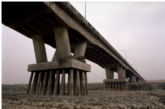
圖十二 濁水溪下游砂石過度採挖造成自強大橋橋墩外露（鄧坤海攝影、提供）
