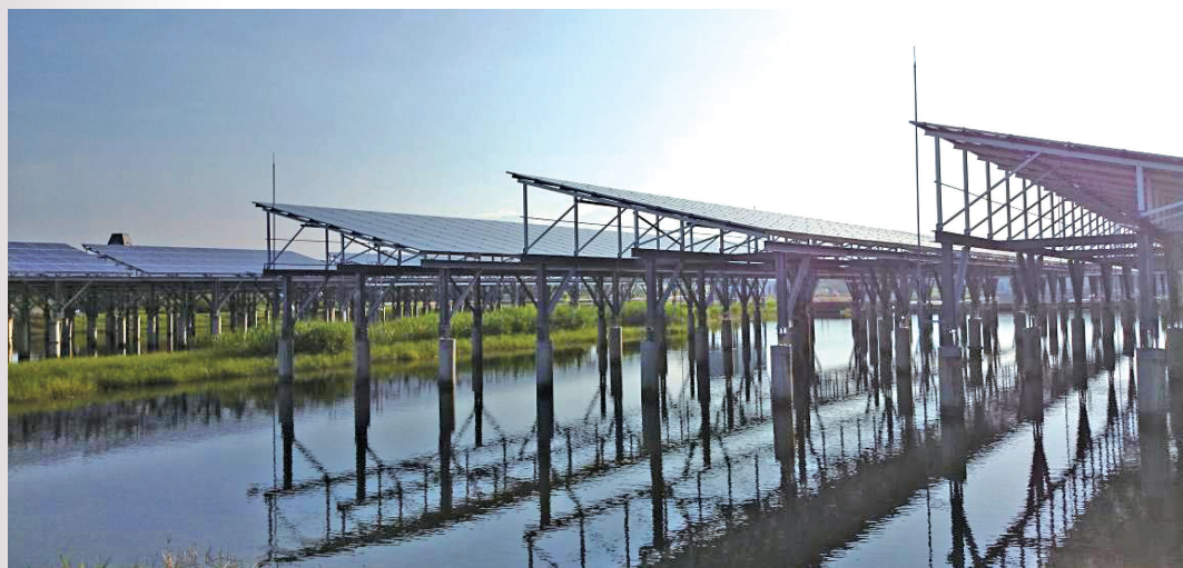
圖 13: 養水種電部分區域太陽能板下方可以作為滯洪與濕地淨化的水域空間。
