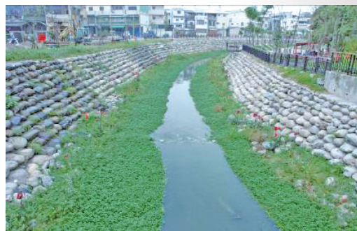
圖 4：萬年溪整治時利用乾砌卵石打造護坡，進行礫間淨化及河岸生態工法。
